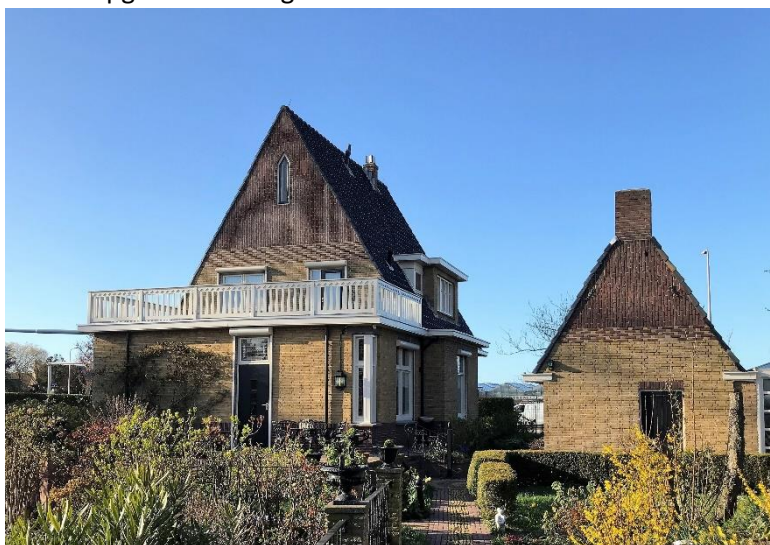
Achterzijde van de woning
